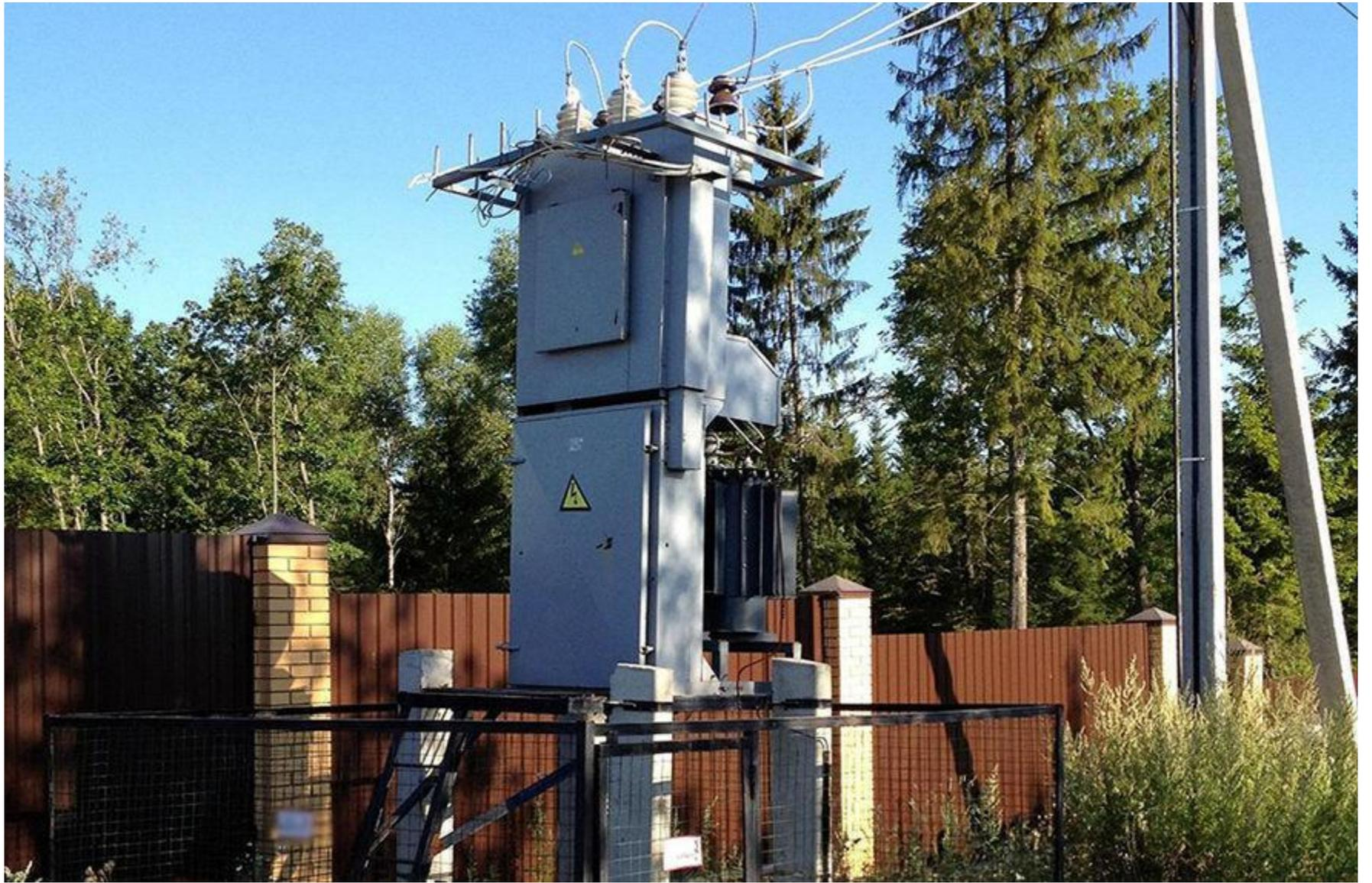
МТП с сухим трансформатором могут устанавливаться вблизи ответственных объектов инфраструктуры, т.к. не содержат трансформаторного масла.
