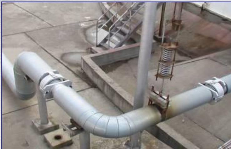
Двухшарнирная схема в Z-образной системе Изменение длины короткого участка 2 минимально и в расчет не принимается.
