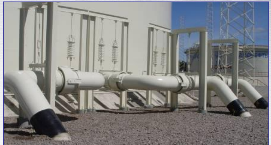
Трёхшарнирная схема в Z-образной системе Компенсатор на участке 1 для восприятия перемещения вертикального участка 2.
