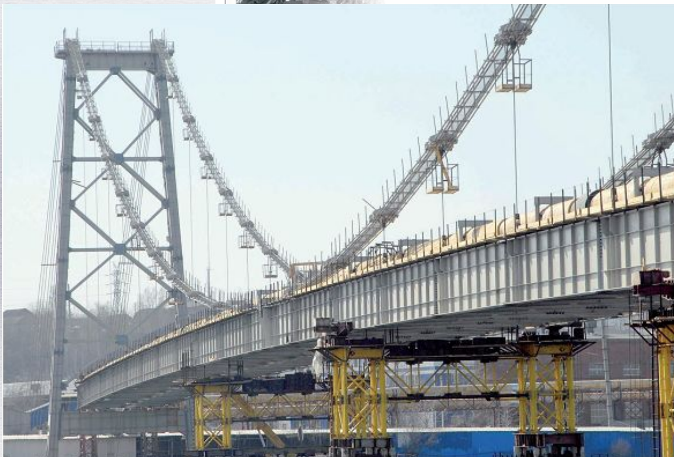
Вантовый мост через Ангару длиной 301 м для теплопровода DN 1000
