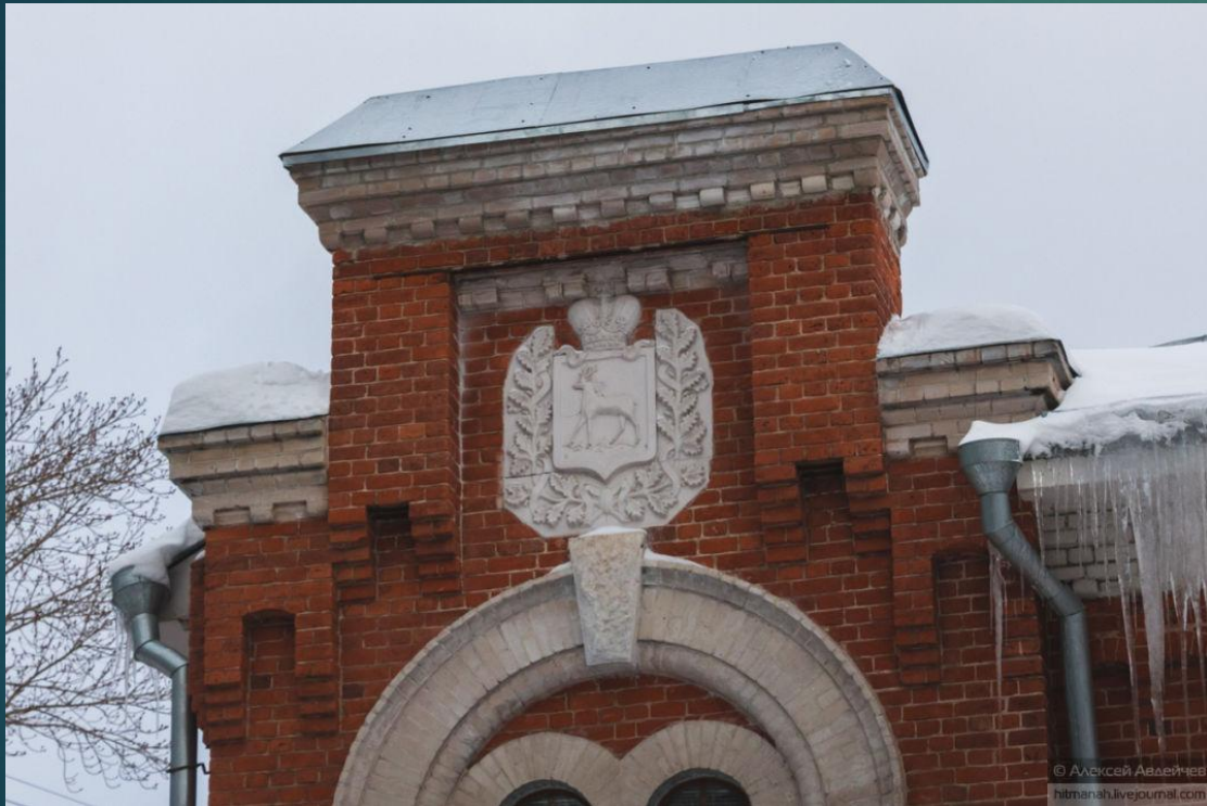
Здание пожарной части на улице Чернореченской
