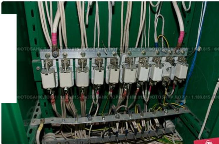
Распределительный щит ВРУ. Сборки предохранителей.
