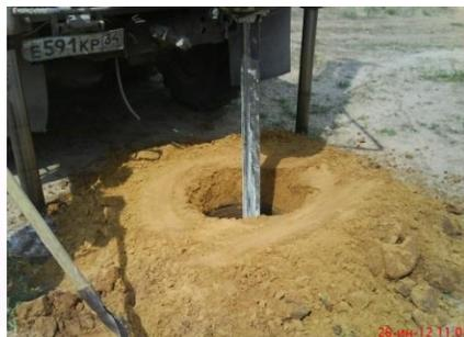
Пробурить скважину диаметром 150 мм
