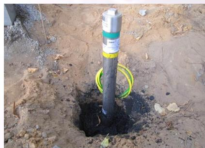
Утрамбовать материал оптимизации заземления, произвести проливку водой
