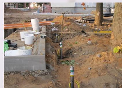
Подсоединить заземляющие проводники электродов к контуру заземления
