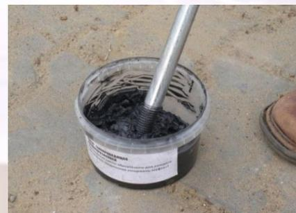
Обработать следующий стержень с двух концов антикоррозионной смазкой
