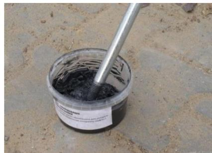
Резьбовую часть с противоположного конца стержня обработать антикоррозионной смазкой
