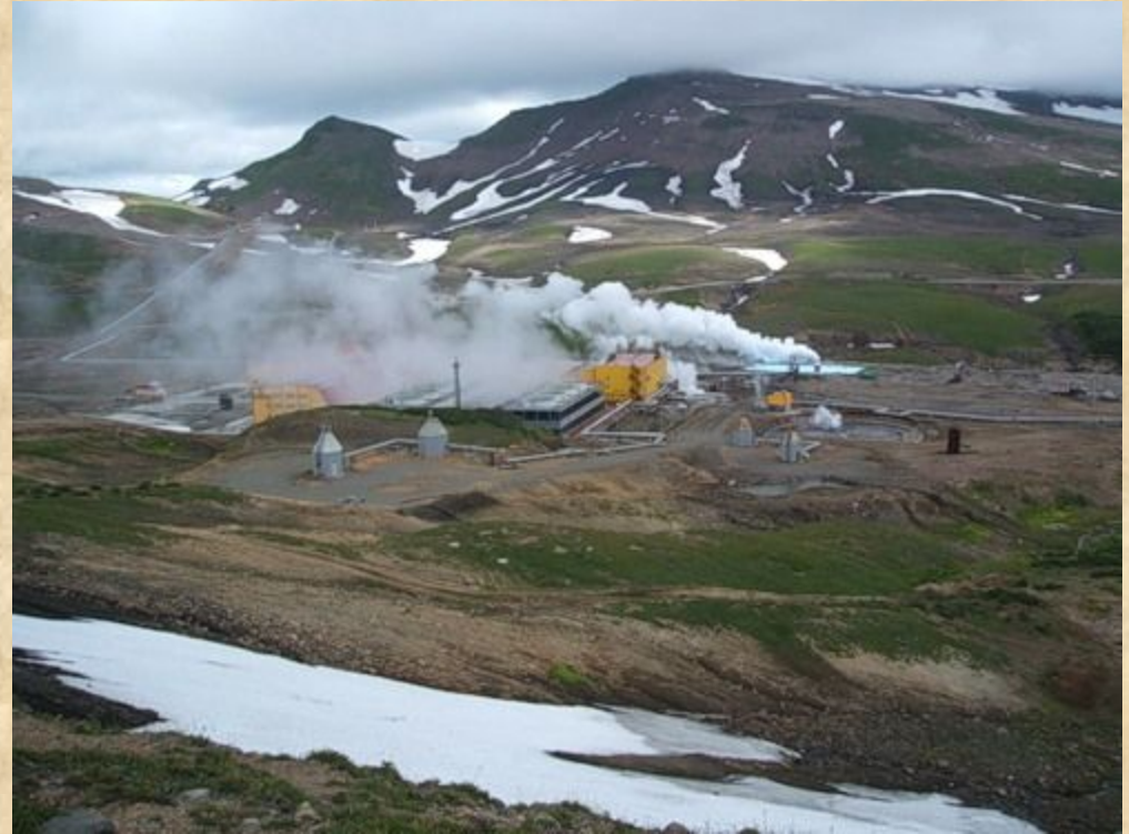
Мутновская геотермальная станция
