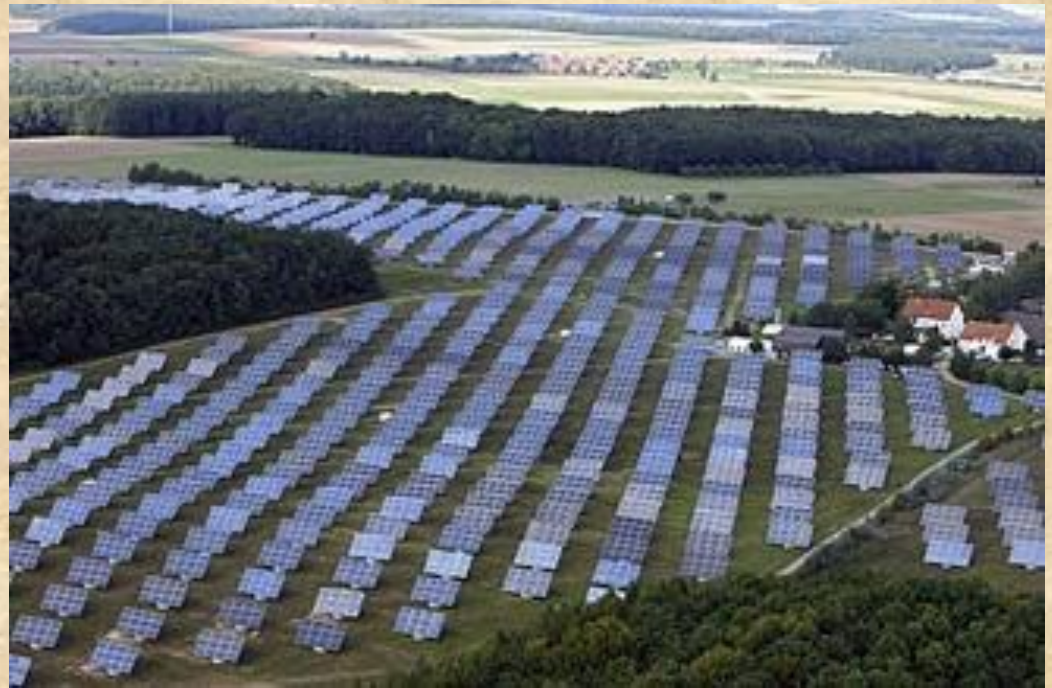
Солнечная электростанция в Германии
