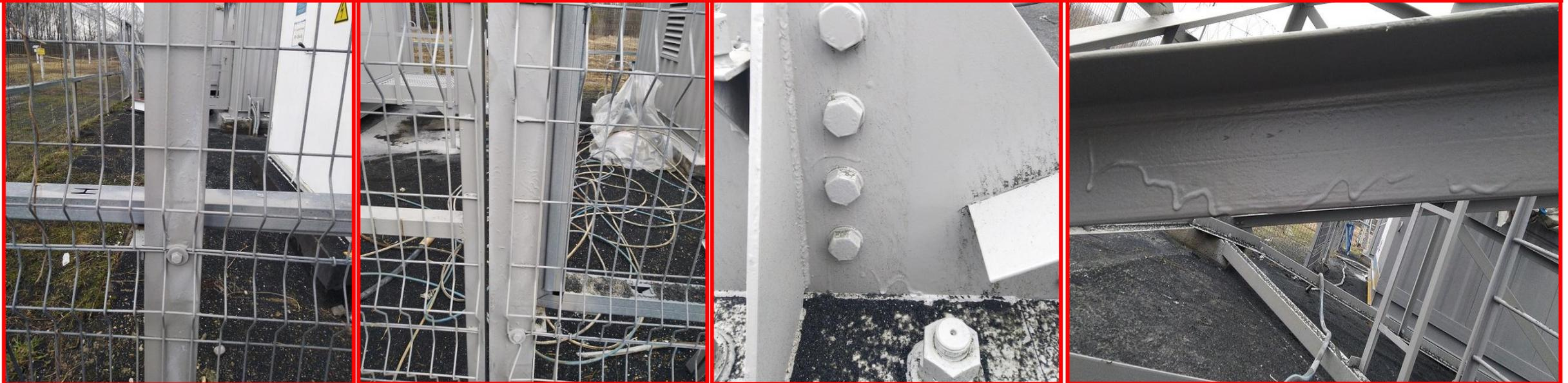
Инженером СКК не проконтролировано и не выявлено нарушение, а именно: при освидетельствовании работ по нанесению грунтового состава на металл конструкции АМС, опор ограждения БС "Горный" выявлено, что на огрунтованной поверхности имеются потеки, непрокрасы, количество твердых включений более 1шт./дм<sup>2</sup>, размер включений более 1мм, расстояние между включениями менее 10 мм, пропуски.
