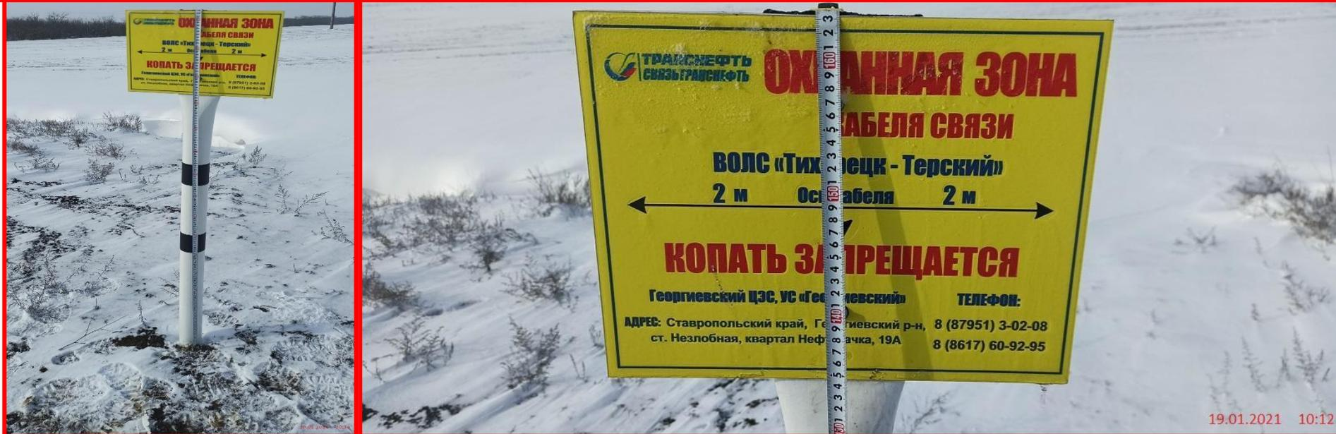
Инженером СКК не проконтролировано и не выявлено нарушение, а именно: при проверке качества общестроительных работ (установка столбиков опознавательных для подземных кабельных линий связи «СОС -2.5 м.») на ПК 430+61, столбик установлен на глубину 870мм с высотой 1630мм (согласно Рабочей документации устанавливается на глубину 700мм с высотой 1800мм)
