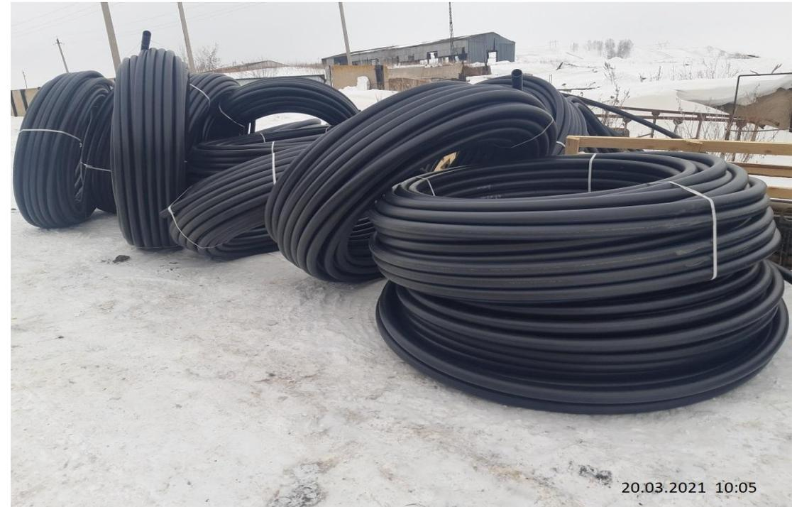
Складирование кожуха для прокладки кабелей, трубы ПЭ100 SDR11-63x5,8 (количеством 3 км), производится непосредственно на снег (навалом), без применения подкладок и прокладок.
