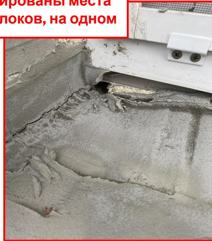
Инженером СКК не проконтролировано и не выявлено нарушение, а именно: не заделаны и не загерметизированы места сопряжений стен и оконных блоков, на одном окне.
