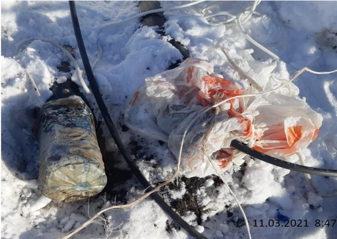
Установленные герметизаторы (2 шт.) не соответствуют требованиям проектной документации. По факту выполнена герметизация концов труб пластиковыми бутылками, согласно требованиям проектной документации, должны быть установлены герметизаторы заводского исполнения.
