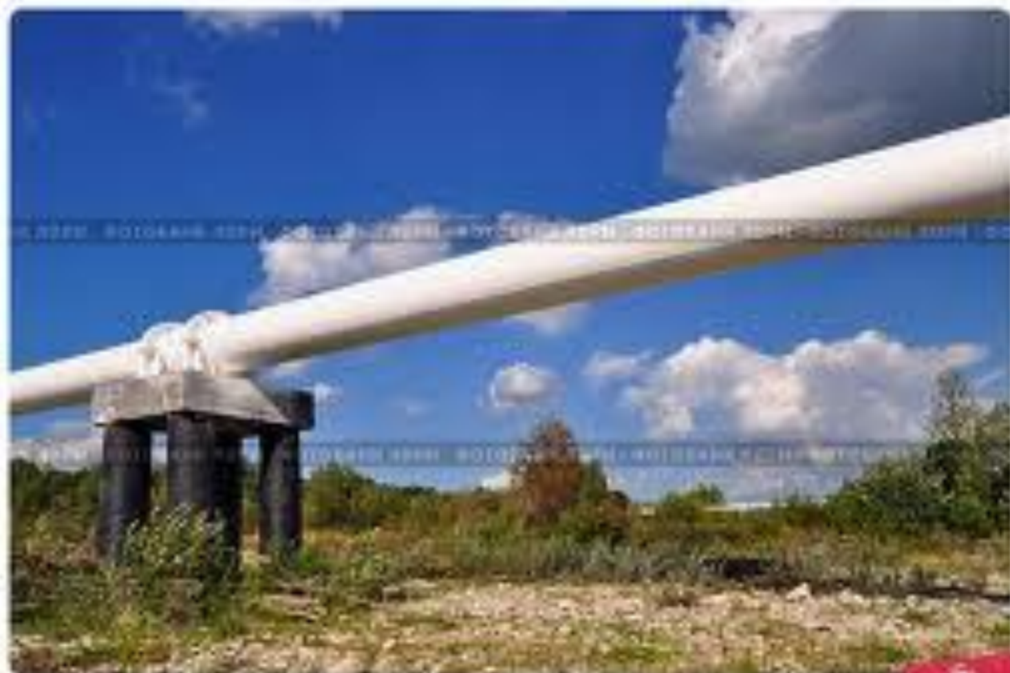
Трубопровод высокого давления в скважине Васильев / Фотобанк Горы
