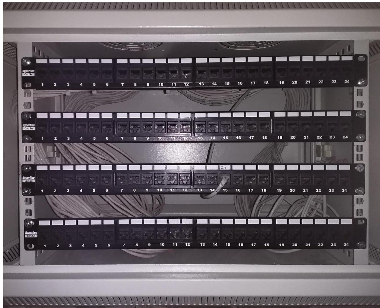
Домовой коммутатор, кабель «витая пара» в каждую квартиру, установка конвертеров предприятий-провайдеров в общую коммутационную стойку.
