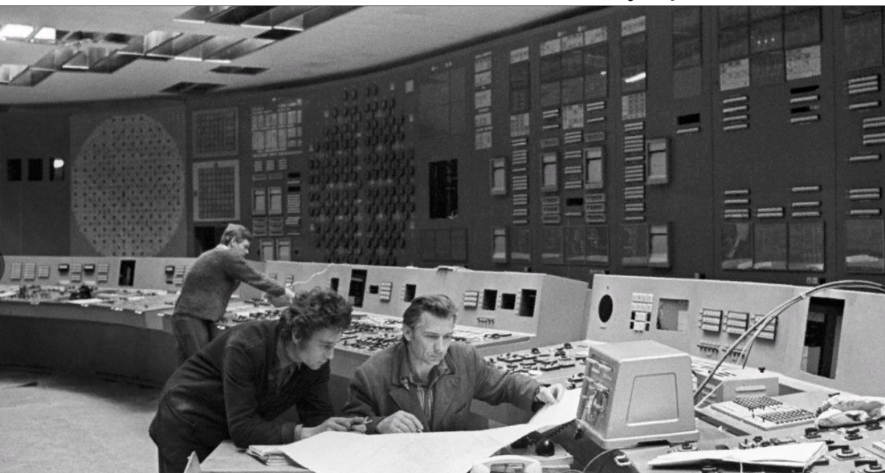
Монтажные работы на пульте управления Чернобыльской АЭС. 23 мая 1977 г.
