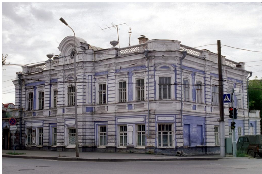
Объект до реконструкции
