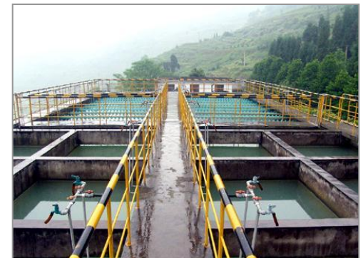
Chongqing Nanchuan Sewage Treatment Plant завод в г. Чунцин по переработке сточных вод
