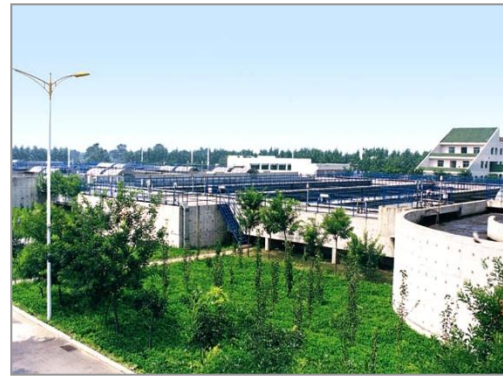
Henan Shangqiu Sewage Treatment Plant станция в г. Хэнань по переработке сточных вод
