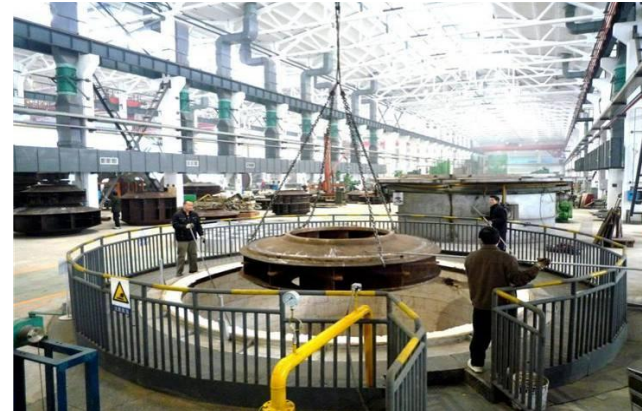
Φ6m annealing furnace ОТЖИГОВАЯ ПЕЧЬ Φ6m
