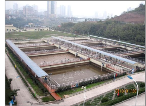
Lijiatuo Sewage Treatment Plant станция в г. Литьято по переработке сточных
