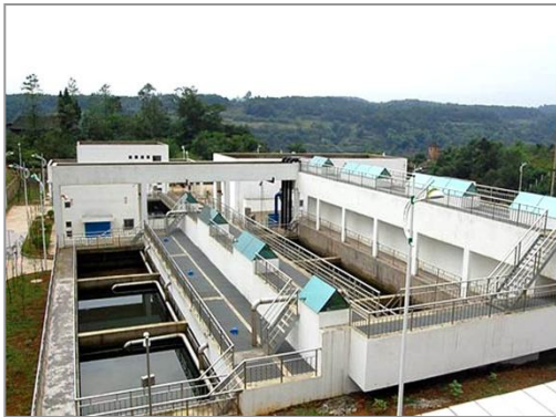
Dazhou Sewage Treatment Plant станция в г. Даджоу по переработке сточных вод
