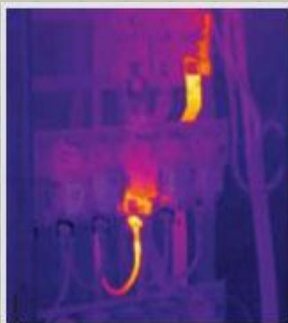
Рис. 9. Перегрев контактного соединения
