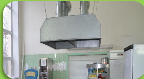
Система вытяжной вентиляции в пищеблоке
