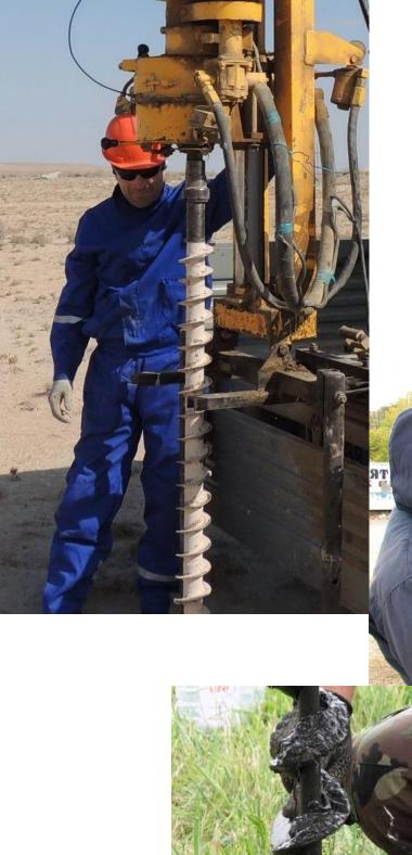
в) шнековое бурение — при невысокой точности (0,5-0,75 м)
