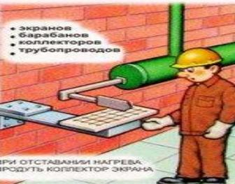
ПРИ ОТСТАВАНИИ НАГРЕВА ПРОДУТЬ КОЛЛЕКТОР ЭКРАНА
