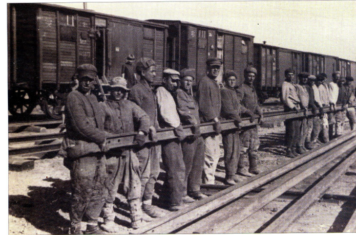
Разгрузка рельсов. Спецконтингент на железнодорожном строительстве. 1940-е гг.
