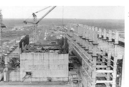
Станция сооружена в три очереди: первая очередь — энергоблоки №1 и № 2 с реактором АМБ, вторая очередь — энергоблок № 3 с реактором БН-600, третья очередь — энергоблок №4 с реактором БН-800.
