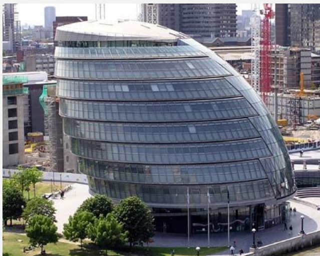
Здание Мэрии (City Hall), Лондон
