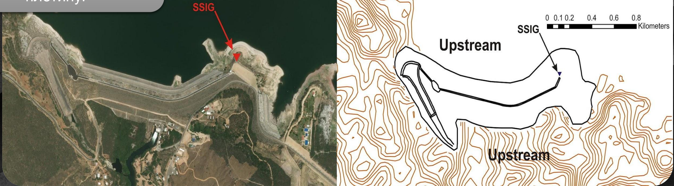
Рис.15 . (а) местоположение антенны GPS и (б) топография, определяющая плотину.
