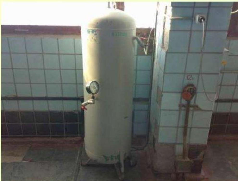
Ресивер с воздухом КИП (2ой этаж высотки). Каждый сосуд под давлением должен быть снабжен предохранительными устройствами (клапанами), манометром.
