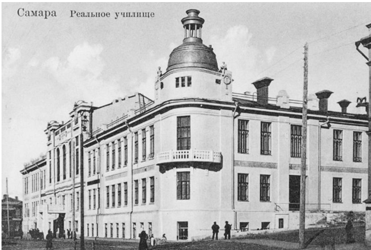
Реальное училище им. Александра III (1908-1910-е). ул. Алексея Толстого, д. 31-33 / ул. Комсомольская, д. 18. Архитектор – Платон Шаманский.
