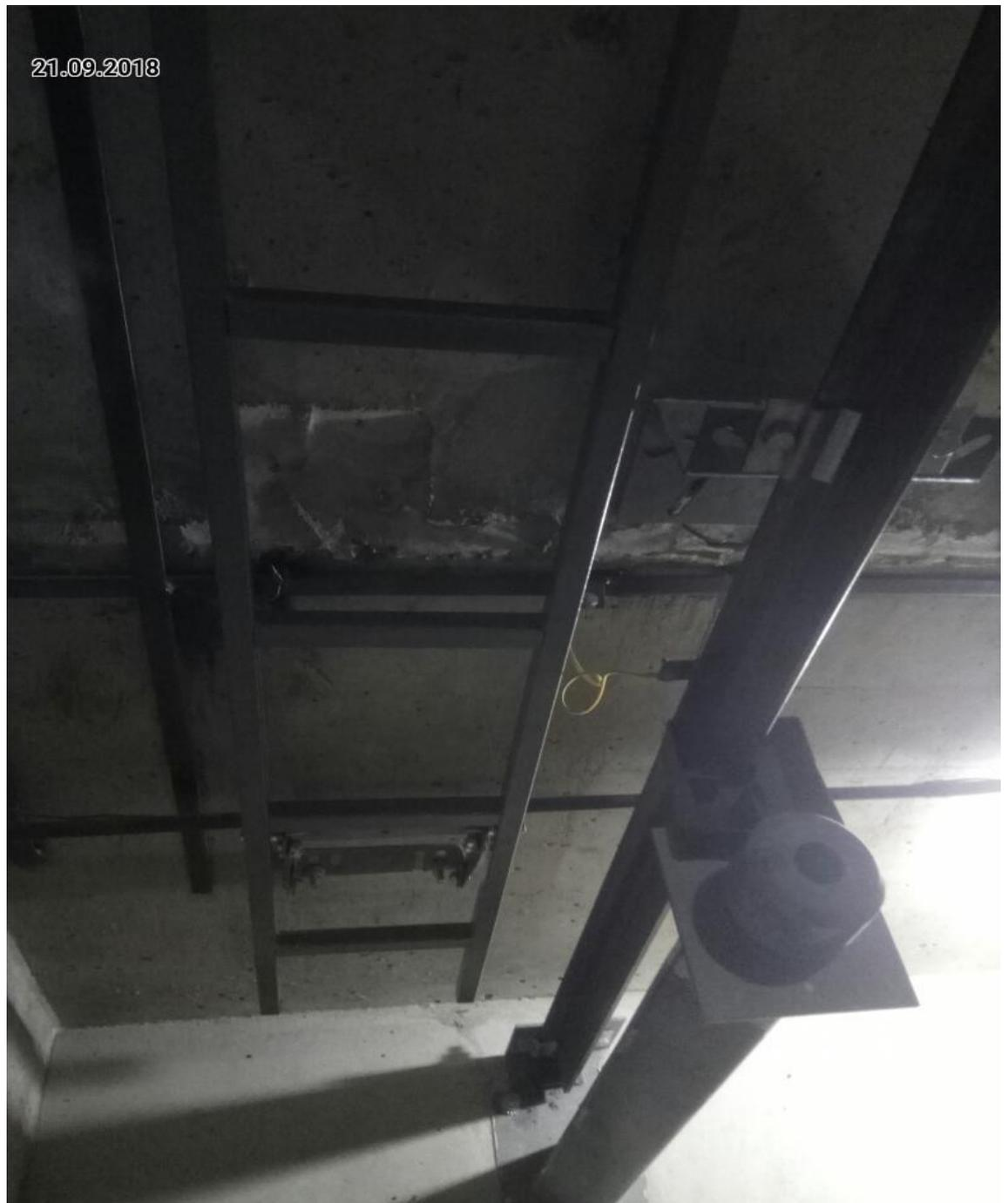
Прямо́к шахты лифта (стяжка пола, направляющие и буфера кабины, противовес)
