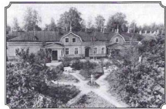
Рантакату. Здание «Сеурахуоне» (Seurahuone). Вид со двора. Фотография, начало XX в.
