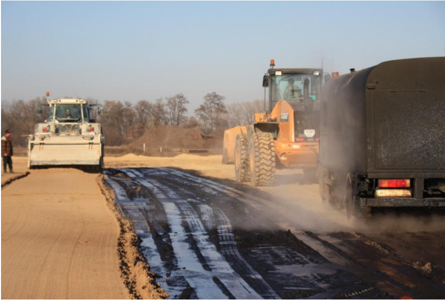
Устройство капилляропрерывающего слоя из битумной эмульсии
