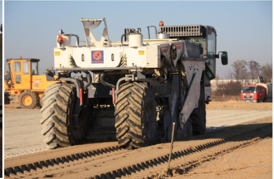
Устройство грунтоцементного основания ресайклером на глубину 30 см по методу смешивания на месте
