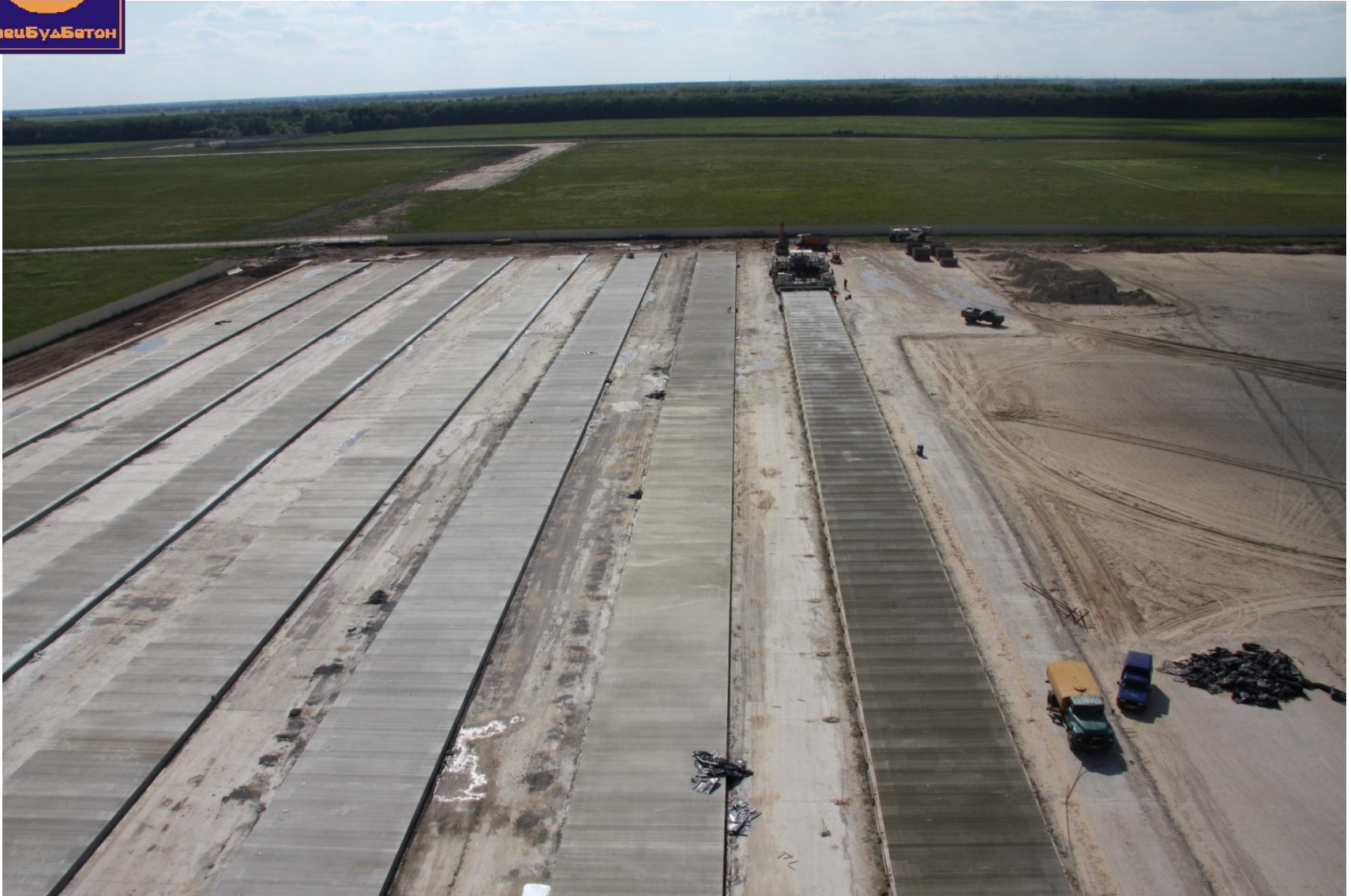
Устройство «тощего» бетона М 100 скользящей опалубкой бетоноукладчиком SP-850
