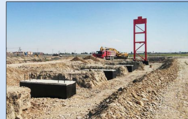
Возведение первой колонны (июль 2017г.)
