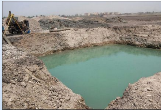
Работы по водопонижению на строительной площадке (июль 2017г.)
