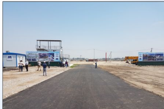
Устройство подъездной автодороги к строительной площадке (июль 2017г.)
