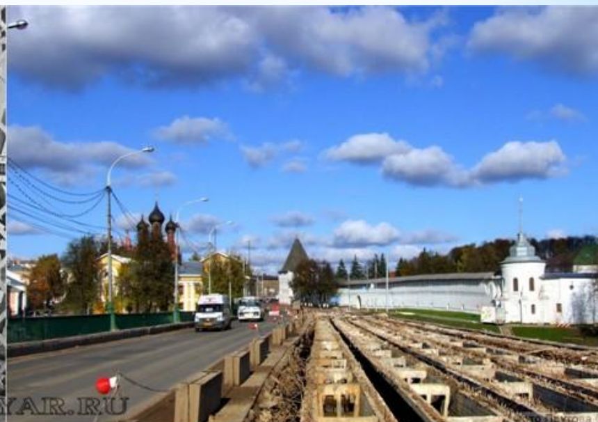
Реконструкция моста через реку Которосьль.
