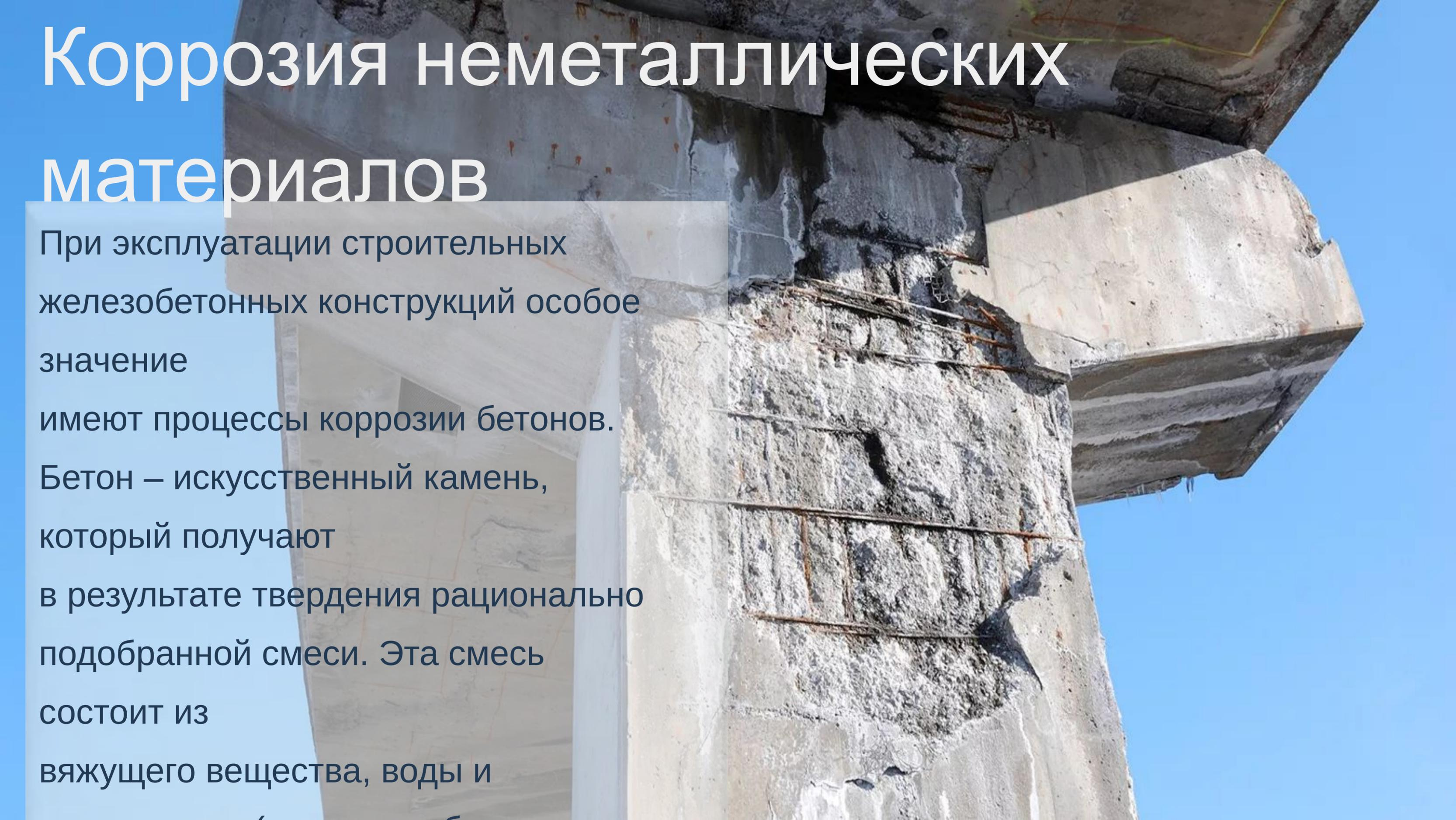
При эксплуатации строительных железобетонных конструкций особое значение имеют процессы коррозии бетонов. Бетон – искусственный камень, который получают в результате твердения рационально подобранной смеси. Эта смесь состоит из вяжущего вещества, воды и
