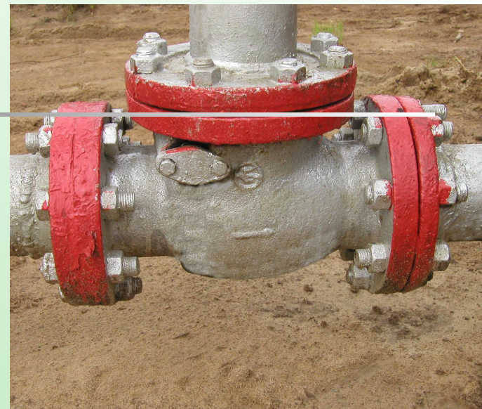
Обвязка устья скважины
