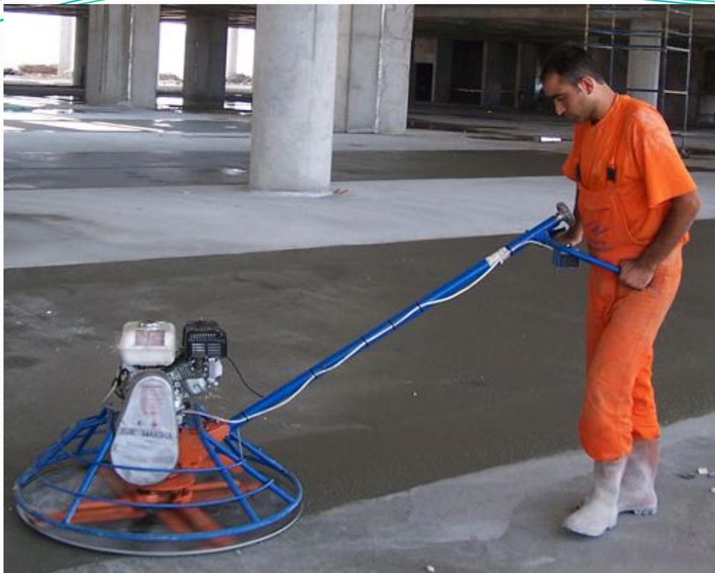
**Затирочная машина**— специальное строительное оборудование для механического заглаживания и затирки свежеложенных бетонных поверхностей, гипсовых и цементно-песочных стяжек, под такие напольные покрытия как плитка ПВХ, линолеум, ковролин и т.п..
