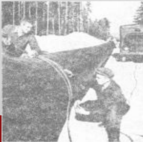
Будівництво газопроводу Шебелинка- Острозька. 1960 р.
