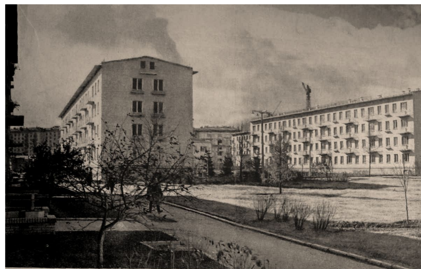
9-й квартал Новых Черемушек. Общий вид жилой застройки
