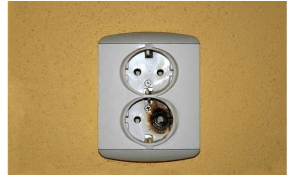
Из-за неплотного контакта вилок в гнездах штепсельной розетки происходит сильный разогрев розетки, а это может вызвать самовоспламенение деревянных подрозетников, горючих перегородок и стен, на которых смонтирована штепсельная розетка.
