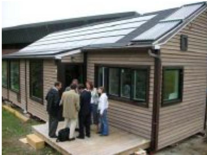
Расход энергии на отопление – максимум 15 KWh/m<sup>2</sup> в год
