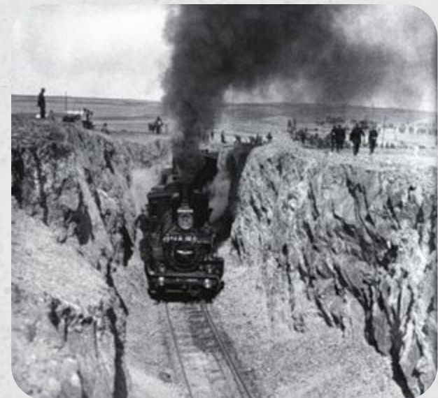
Туркестано-Сибирская железная дорога
