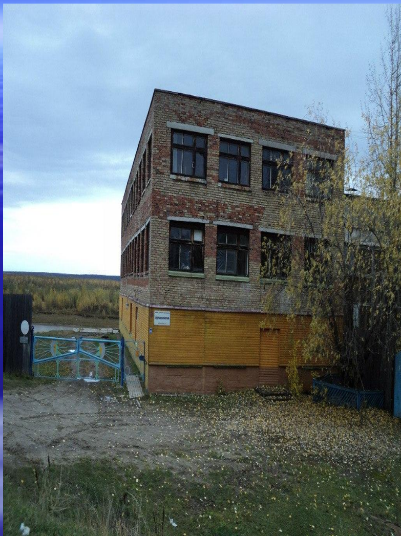
Здание ремонтно – эксплуатационной базы в Щельяуре.
