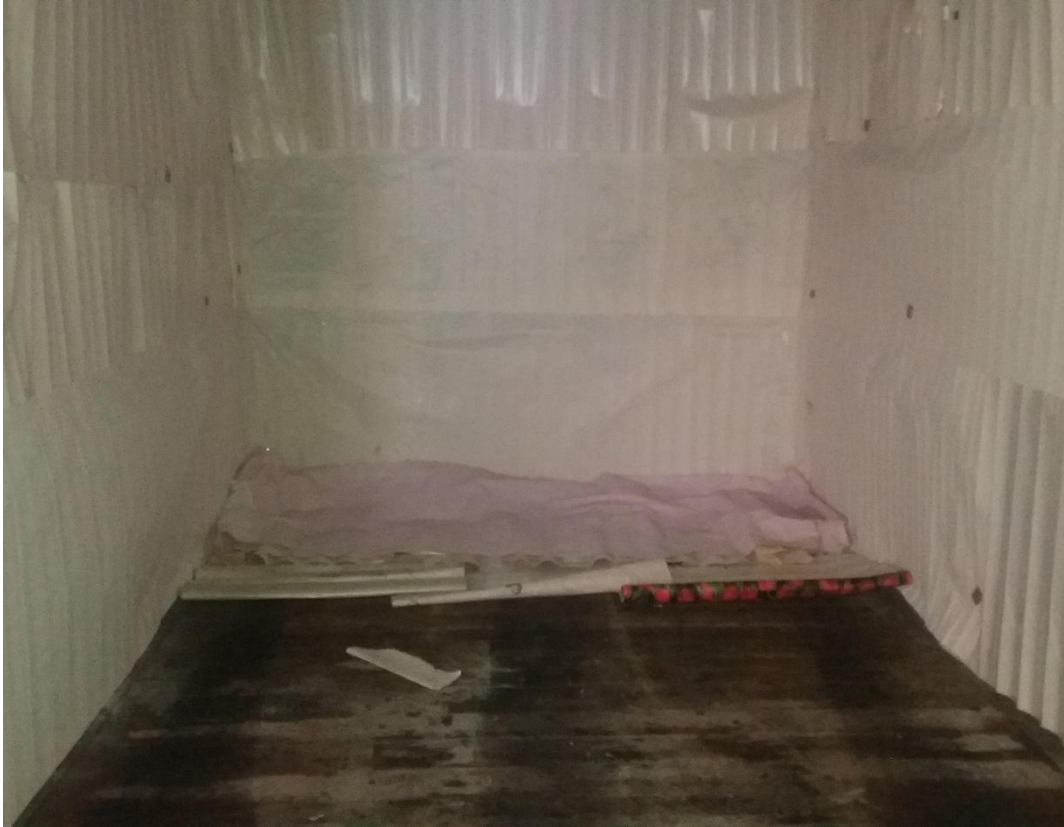
Перед укладанням біг-бегів підлогу застелити трьома шарами шпалер
