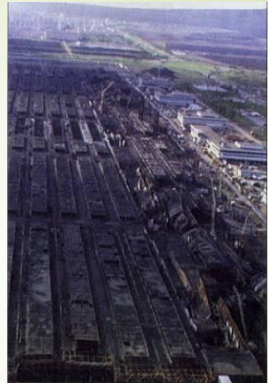
Последствия пожара на заводе двигателей АО «КамАЗ»
