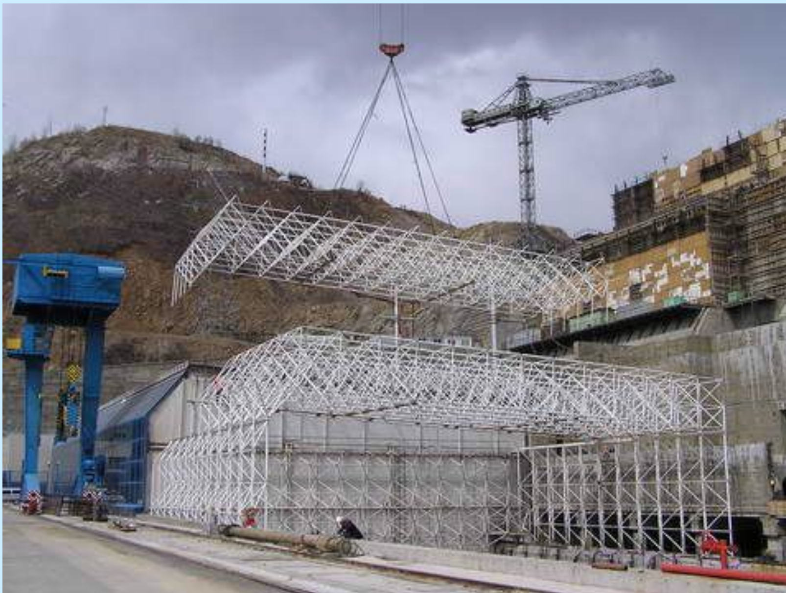
Рис. 3.1. Общий вид структурного покрытия
