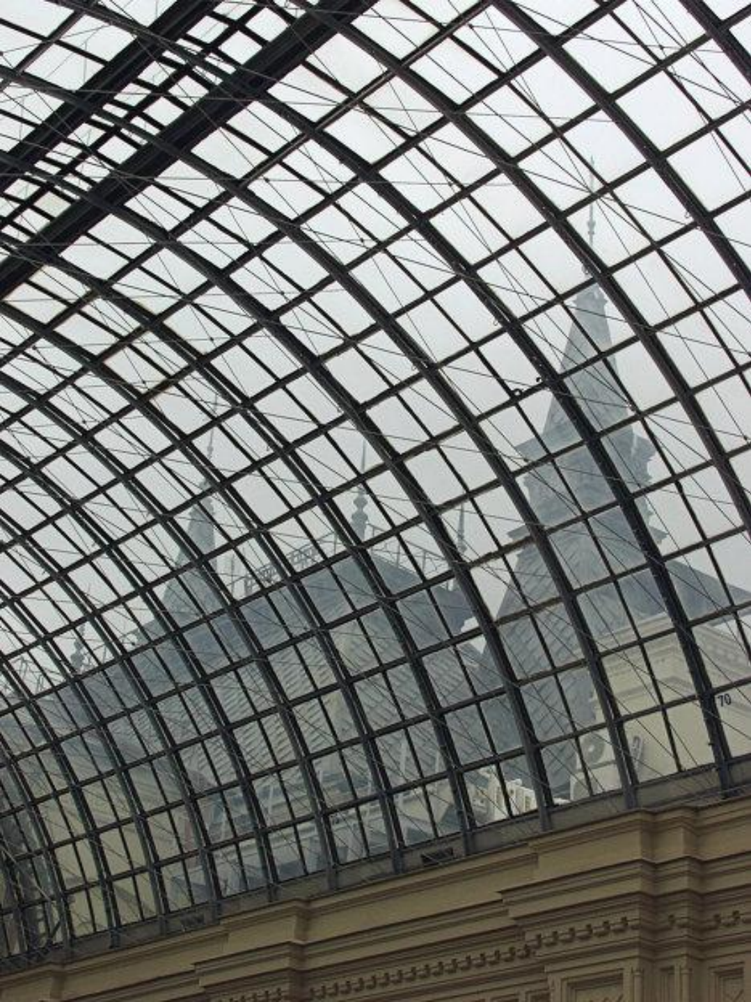
Рис. 3.11. Общий вид свода в ГУМе, г. Москва
