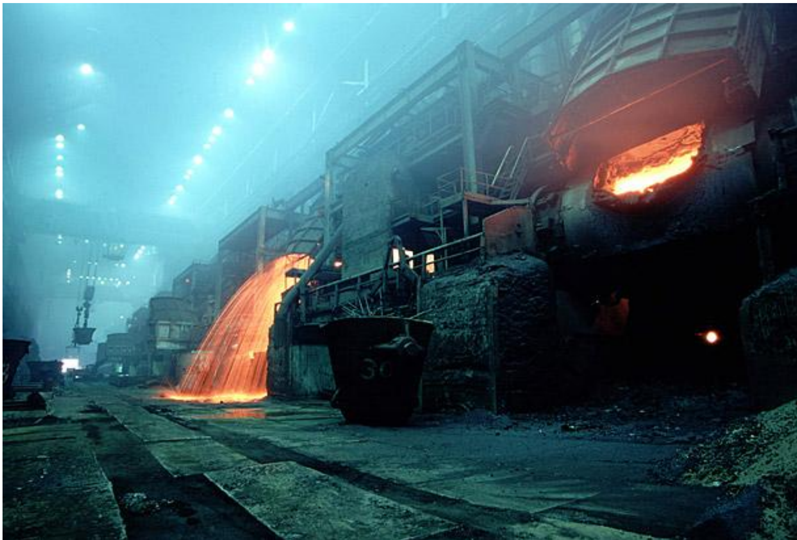
Норильский металлургический завод. Конвертерный пролет.
