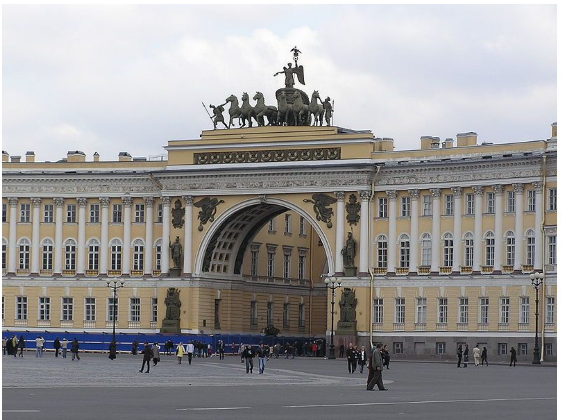
Арка Главного входа
