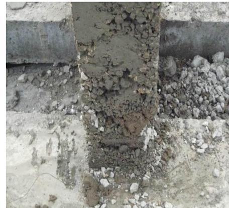
Раковины и каверны возникают также из-за недостаточного уплотнения бетонной смеси при ее укладке в опалубке. Образование раковин и каверн может значительно снизить несущую способность элементов, увеличить проницаемость конструкций; оно способствует коррозии арматуры, находящейся в зоне раковин и каверн, а также может стать причиной продергивания арматуры в бетоне.
