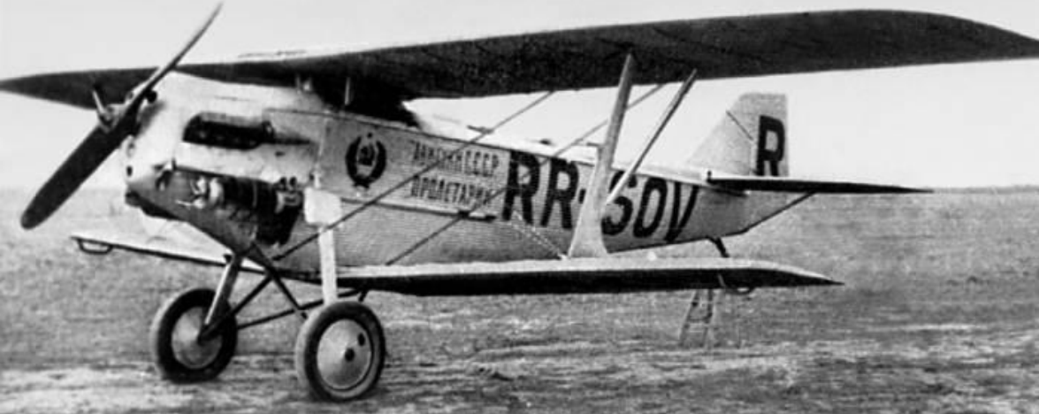
АНТ-3 «Пролетарий» – разведчик Р-3, переоборудованный для рекордного перелета по Европе
