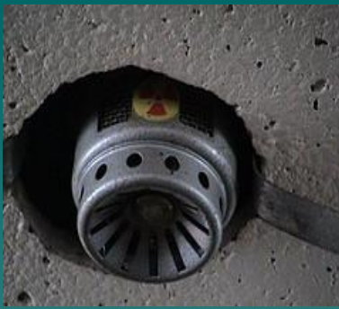
Радиоизотопный дымовой извещатель КИ-1
