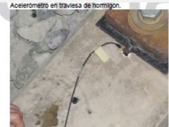
Colocación del cableado.
