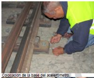
Colocación de la base del acelerómetro.
