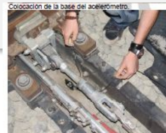
Acelerómetro en traviesa cañón.
