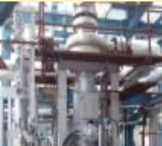
Насос вертикальный гермитичный
