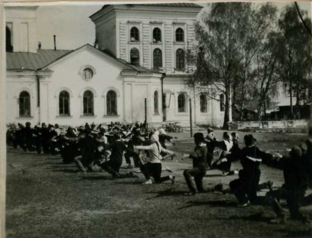
ШКОЛА ПОСЛЕ РЕМОНТА
