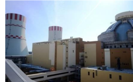
Russia, Novovoronezh NPP II, Unit 1 - 1200 MW
