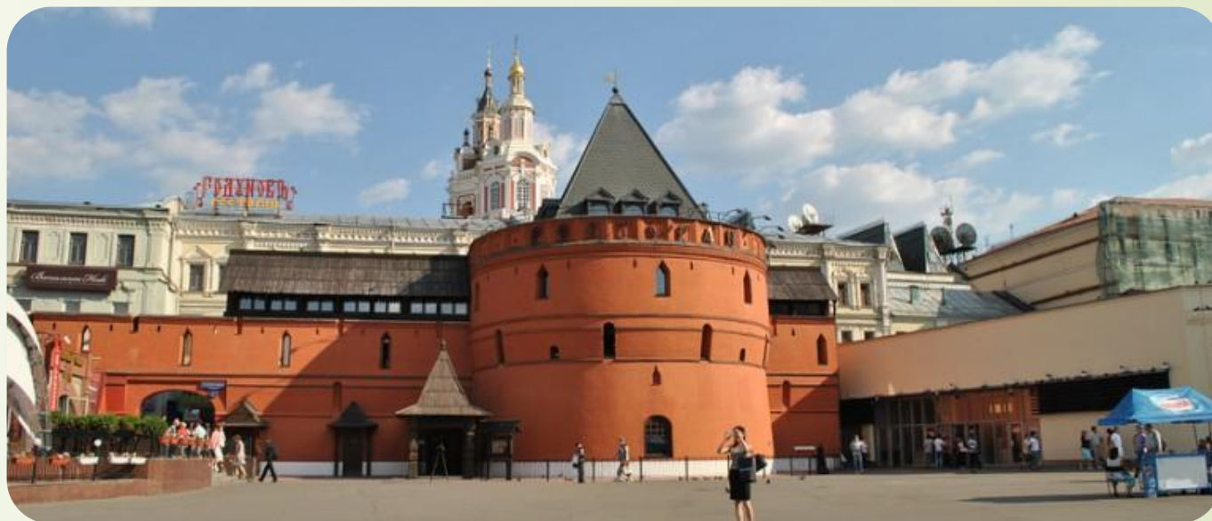
Китайгородская стена , г. Москва (1535—1538)
