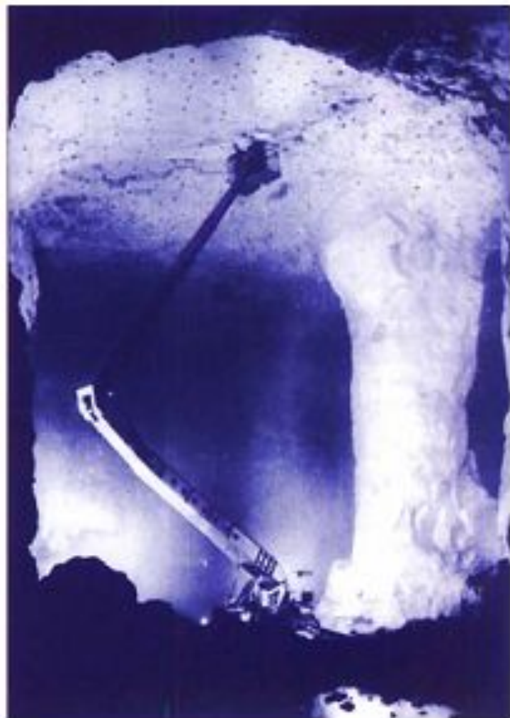
Камерно-столбовая система разработки в Жезказгане в 70-х годах
