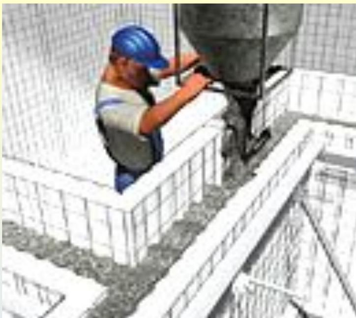
Не снимается по окончании бетонирования, а остается в качестве облицовки или утеплителя.
